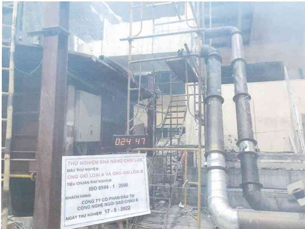
Ảnh D.4: Hệ thống mẫu thử tại thời điểm phút thứ 25 của quá trình thử nghiệm
