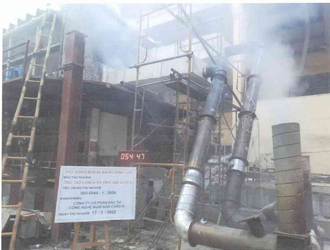
Ảnh D.7: Hệ thống mẫu thử ở thời điểm phút thứ 55 của quá trình thử nghiệm
