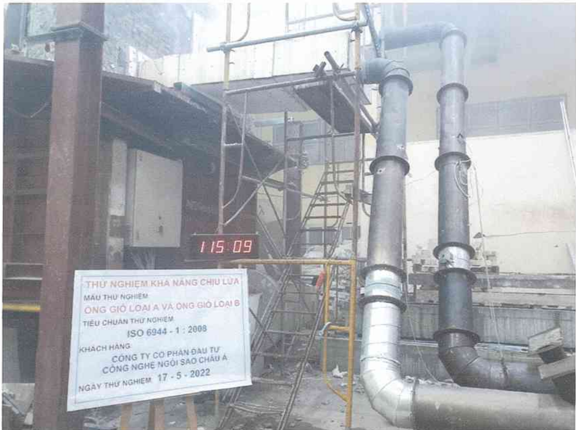
Ảnh D.12: Hệ thống mẫu thử ở thời điểm phút thứ 115 (kết thúc thử nghiệm)
