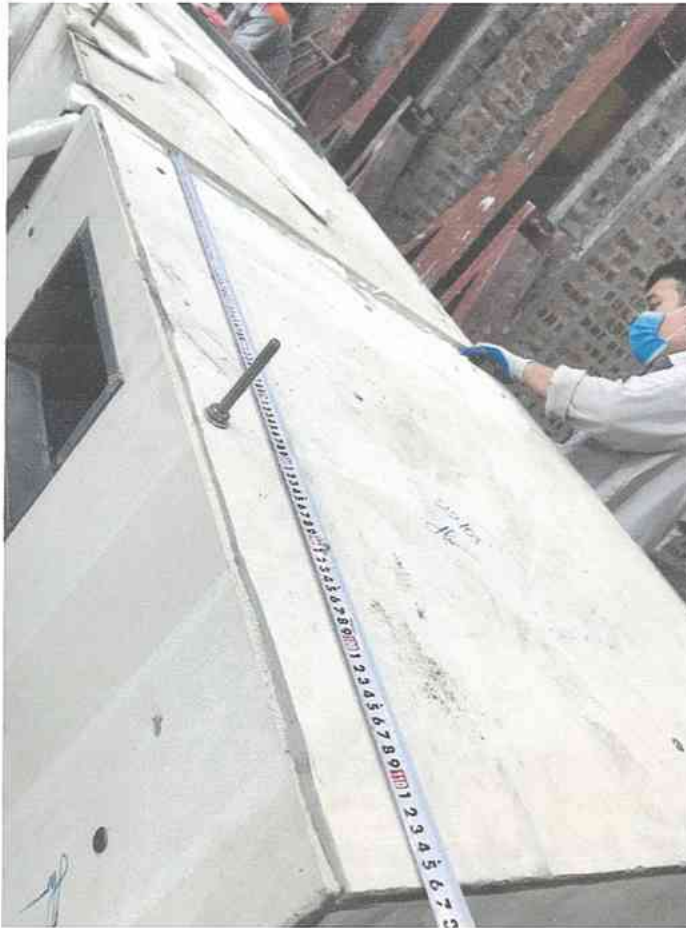
Ảnh D.1: Quá trình lắp dựng mẫu thử được thực hiện bởi các kỹ thuật viên của khách hàng
