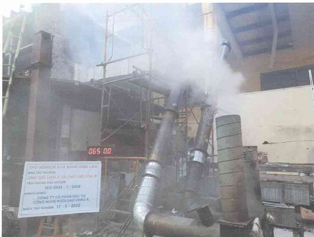
Ảnh D.8: Hệ thống mẫu thử ở thời điểm phút thứ 65 của quá trình thử nghiệm
