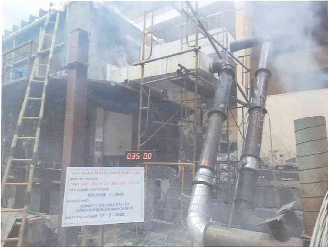
Ảnh D.5: Hệ thống mẫu thử ở thời điểm phút thứ 35 của quá trình thử nghiệm
