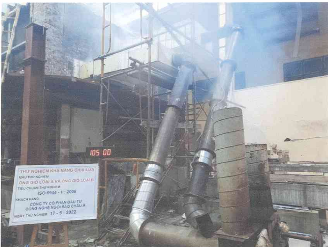
Ảnh D.10: Hệ thống mẫu thử ở thời điểm phút thứ 105 của quá trình thử nghiệm
