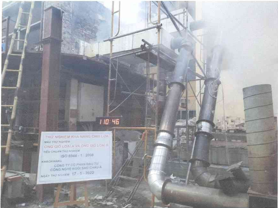
Ảnh D.11: Hệ thống mẫu thử ở thời điểm phút thứ 110 của quá trình thử nghiệm
